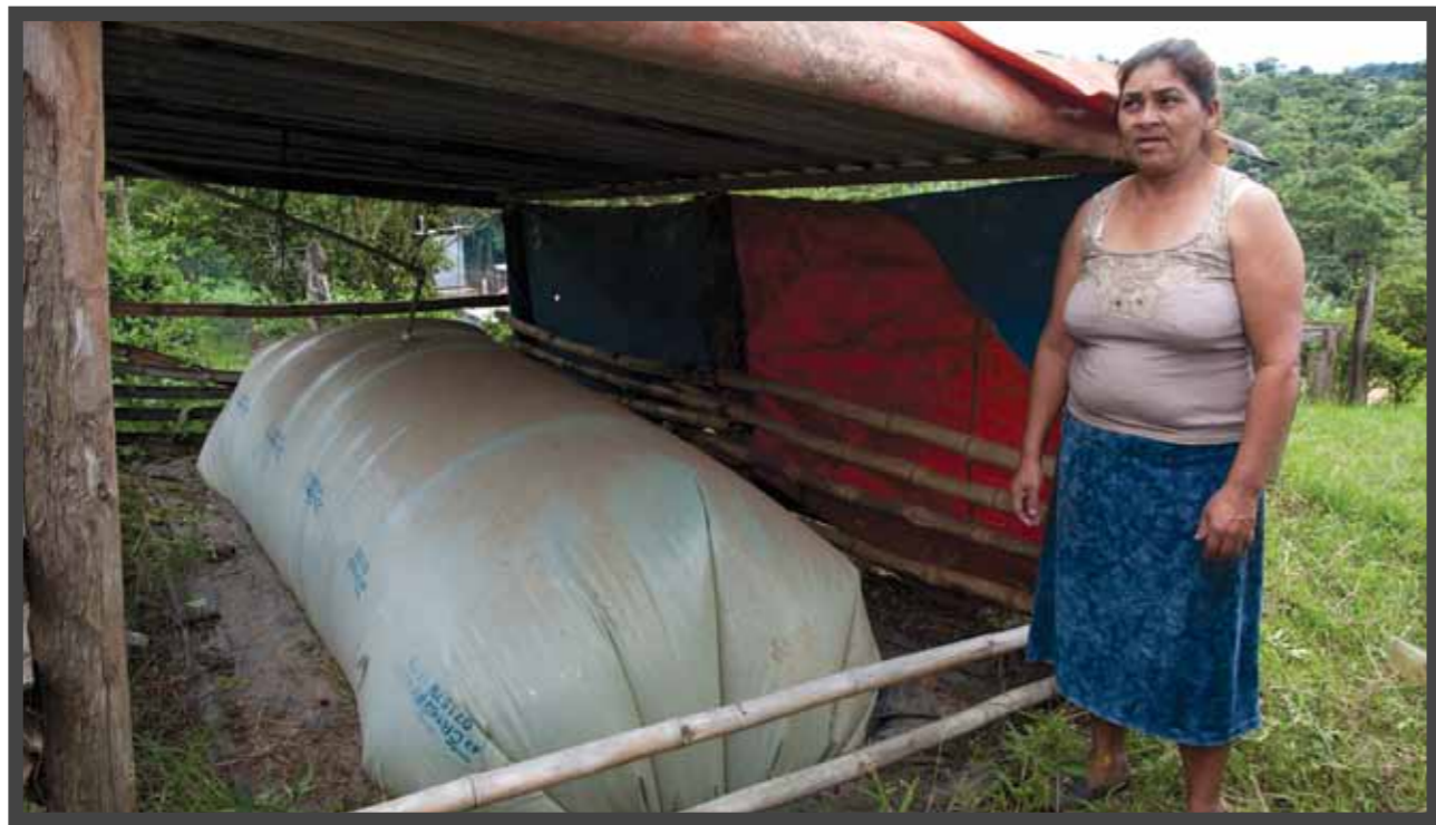
En «biodigestor» er i realiteten et miljøvennlig gasskraftverk, hvor møkk fra husdyr gir gass til komfyren.
