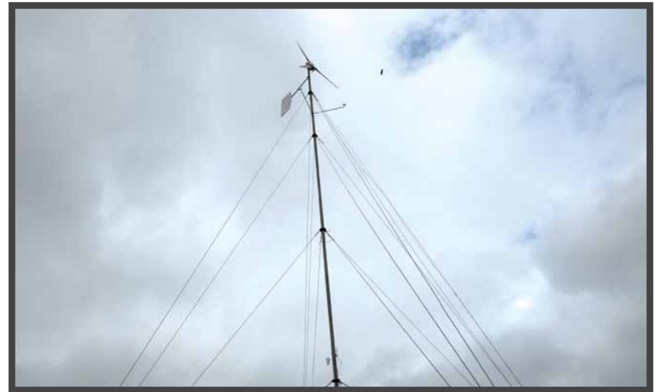
Ikke alle vindmøller må være store for å bidra til bedre energiforsyning. Denne vindmølla på Atlanterhavskysten av Nicaragua kan senkes flatt av ti personer hvis det kommer en orkan.
