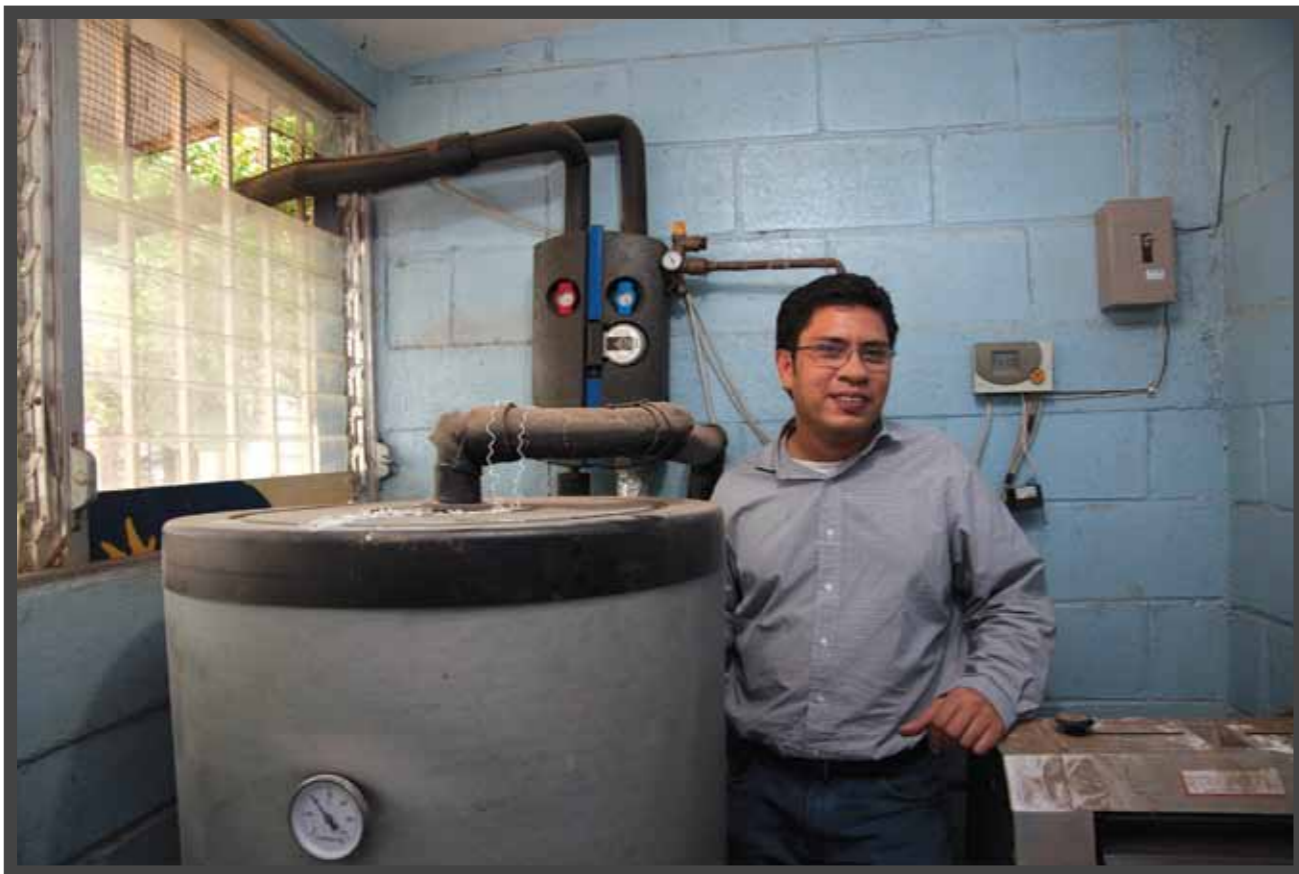
Eddy Blandón viser fram en varmtvannstank hvor vannet varmes opp av en solvarmer på taket i stedet for dyr strøm.
